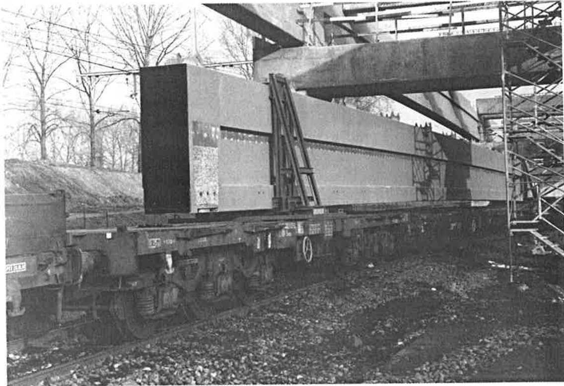
LGV – Une poutre du viaduc «saut de mouton» – Tronçon Ruisbroek–Lot Le 13 décembre 1995–Photo Guy Bridoux.
